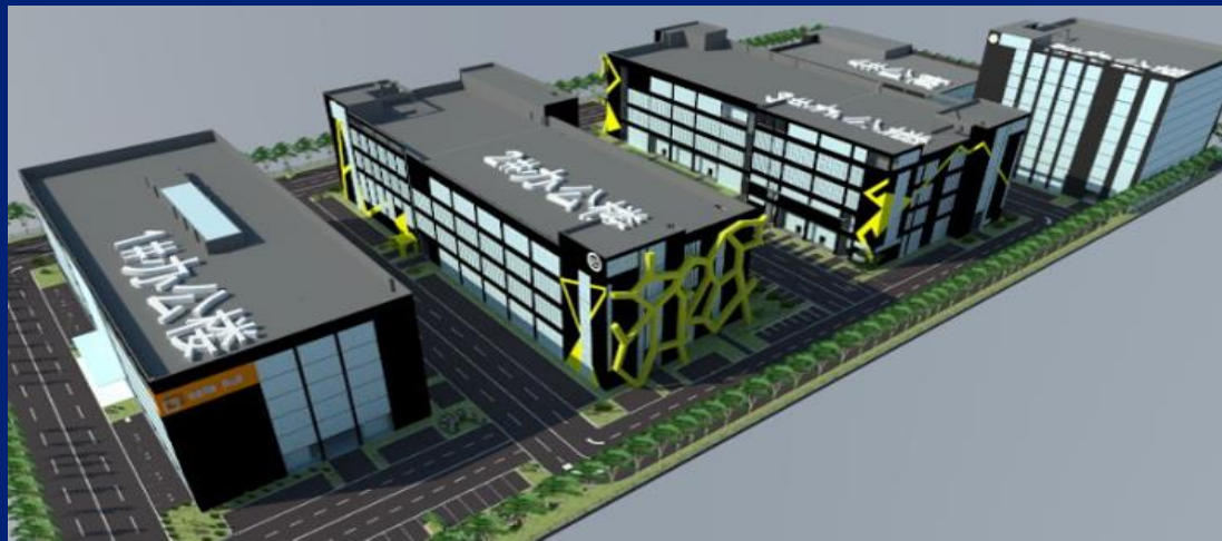
临港同策同心园
